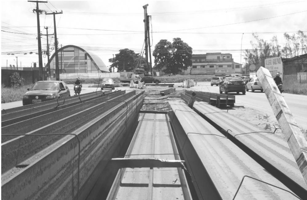
Serviço está na fase de implantação das estacas metálicas, cada uma com cerca de 25 metros de profundidade. Ao todo, serão colocadas 155 dessas estruturas
